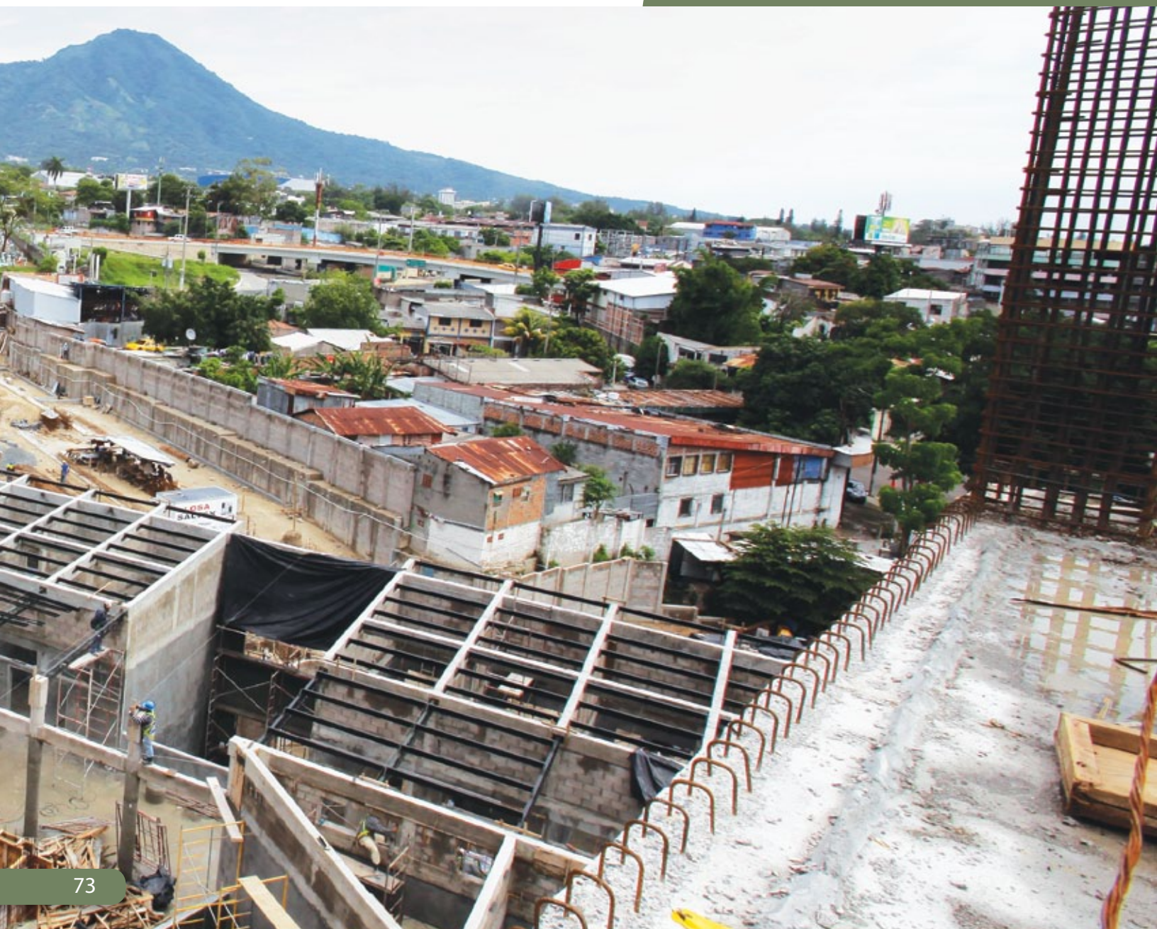
Construcción del Hospital Nacional de Maternidad
