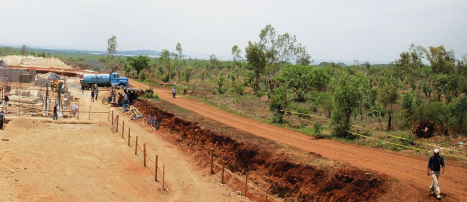
Construcción del Hospital Nacional de La Unión
